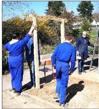
Mise en place progressive des divers éléments
